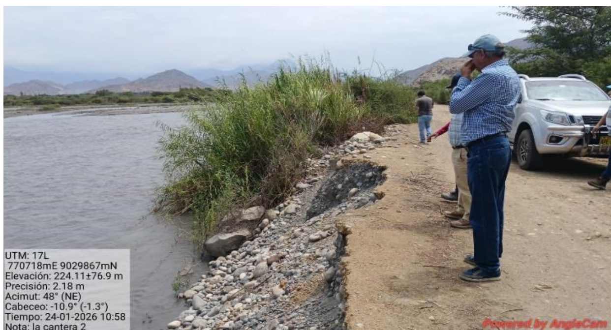
FIGURA N°02: VISTA DE LA EROSION EN LA CARA HUMEDA DEL DIQUE DE LA MARGEN IZQUIERDA DEL RIO - SECTOR LA CANTERA II, REQUIERE PROTECCION CON DIQUE ENROCADO, EN UN TRAMO DE 100 ml.
