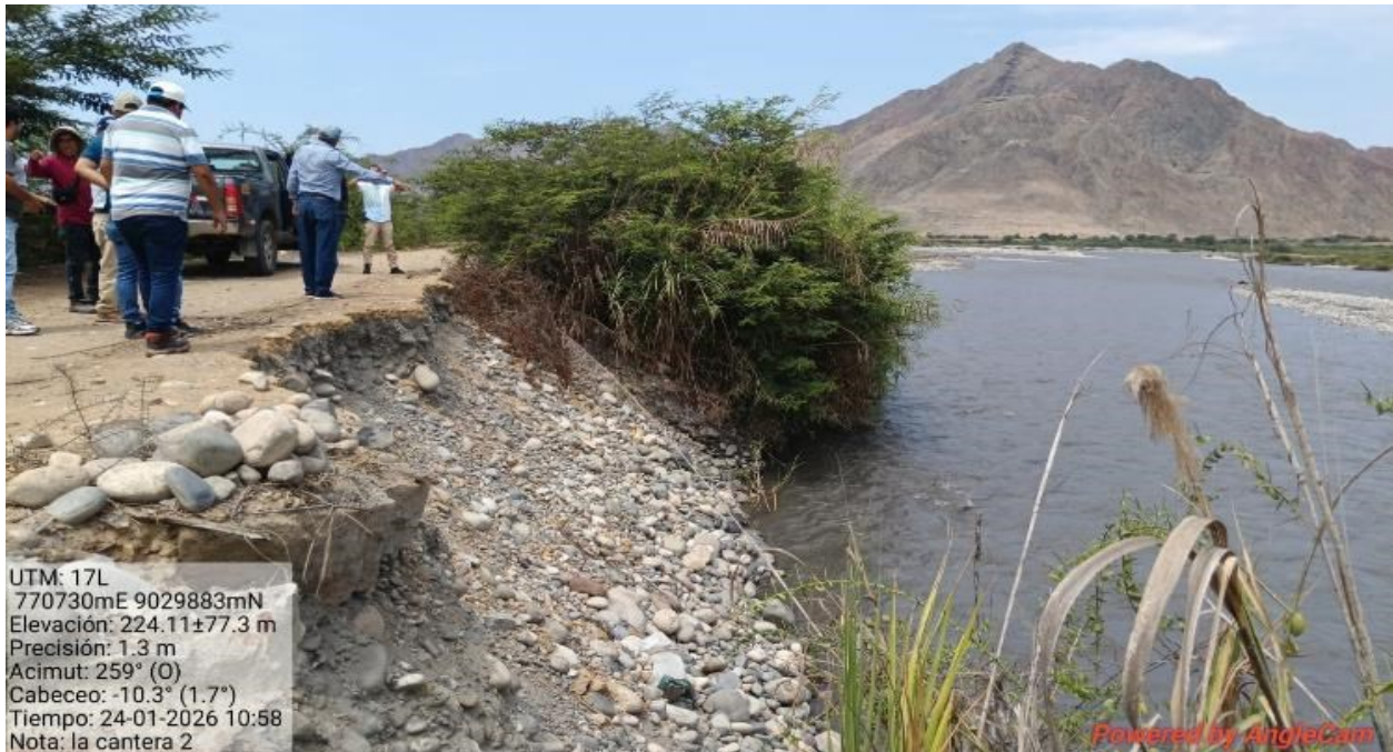
FIGURA N°03: DIQUE EN LA MARGEN IZQUIERDA EROSIONADO PROPENSO A DESBORDE Y AFECTAR AREAS DE CULTIVOS Y POBLACION DEL SECTOR.
