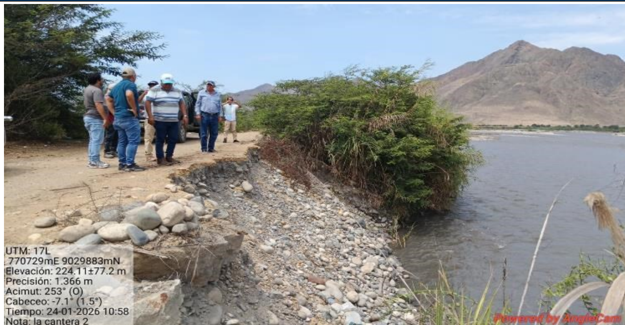
FIGURA N°01: TRAMO CRÍTICO EN EL RÍO SANTA, EROSION DEL DIQUE DEL MARGEN IZQUIERDO Y AFECTACION DE AREAS AGRICOLAS , EN EL SECTOR LA CANTERA II, DISTRITO DE CHIMBOTE, PROVINCIA DE SANTA - ANCASH.
